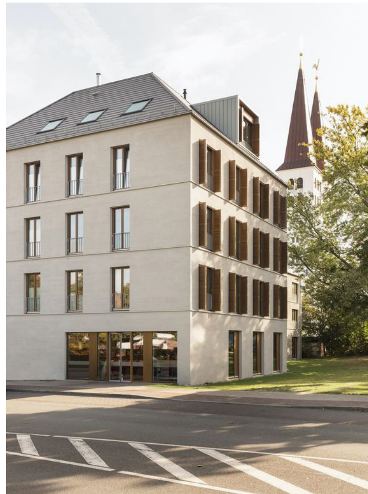
Dakkapel loopt door vanuit gevel
