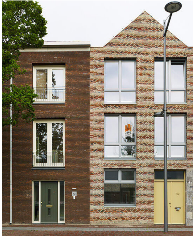
Baksteen gevel met diversificatie in kleur per “huis”
